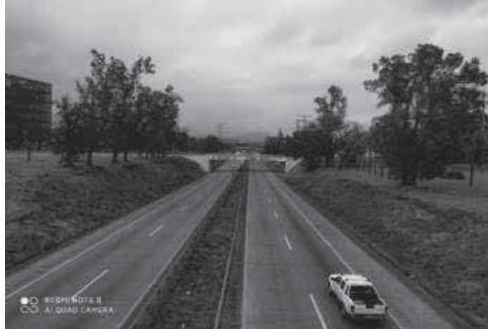
Imagen 2.38 Trébol de entrada y salida de Orizaba. Autopista, vista rumbo a Puebla
