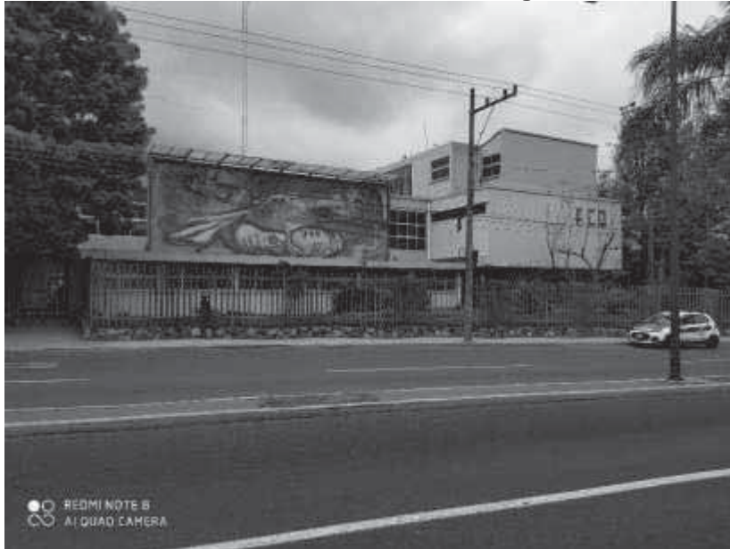
Imagen 2.25 Vista de la Fachada y Mural de la Facultad de Ciencias Químicas de la Universidad Veracruzana. Avenida Prolongación de Oriente 6
